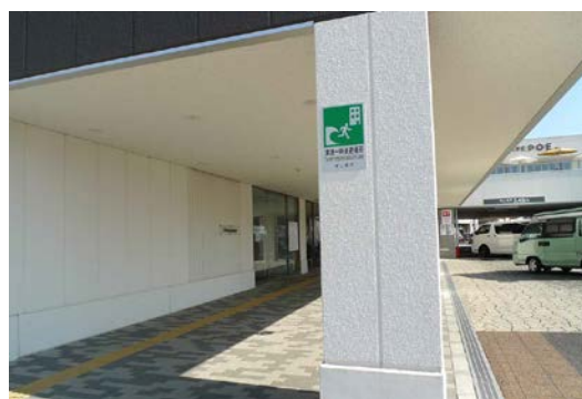
ハマミーナ（茅ヶ崎市南西部複合施設）の設置状況
