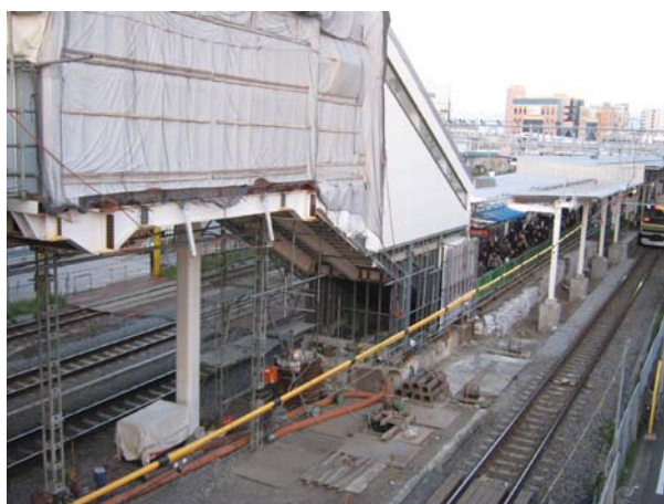
駅舎工事の様子
