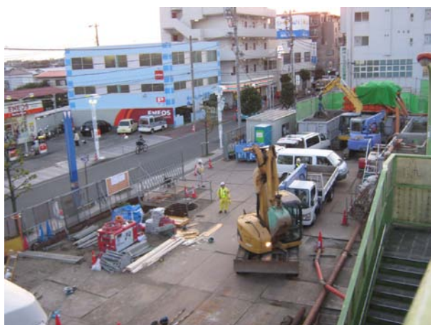
西口南側跨線橋の様子
