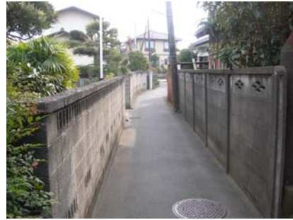
ブロック塀が倒れたら!?
