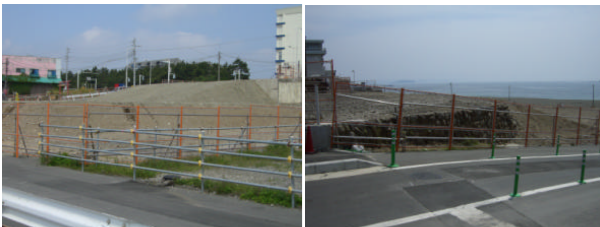
図 マンション工事中断当時の旧フィッシュセンター跡地
