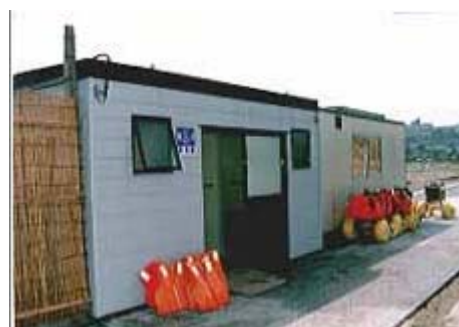
トイレ・シャワー室
