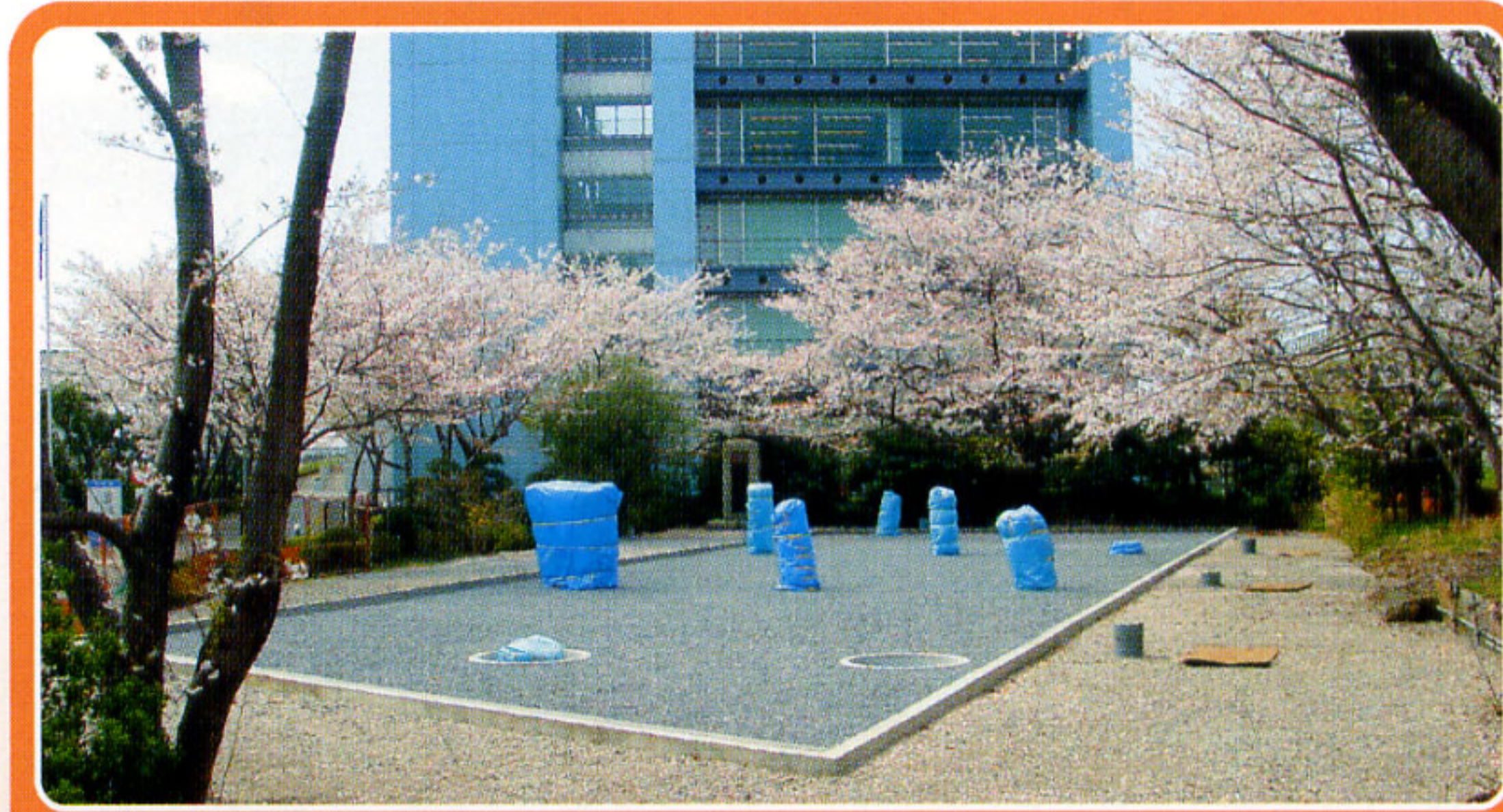
工事中【平成19(2007)年4月】
