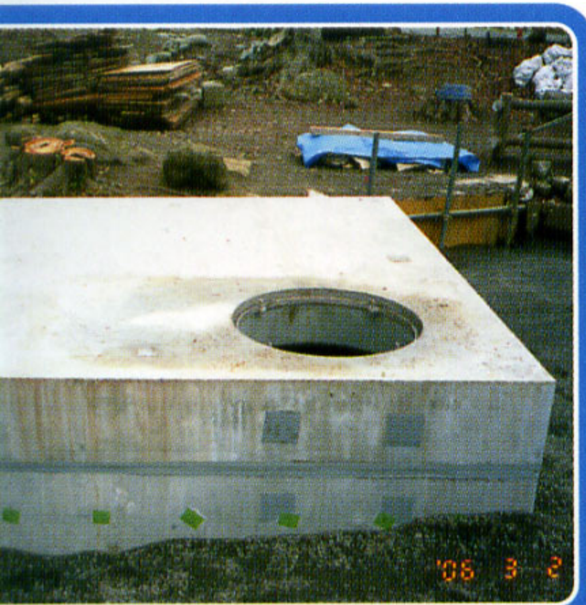
かんせい 、ピット完成
