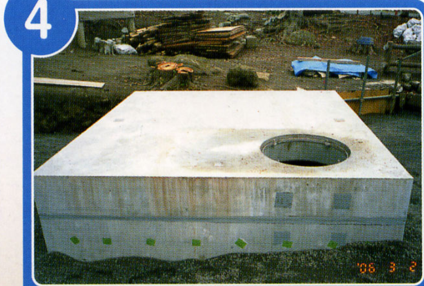
ふたをして、ピット完成
