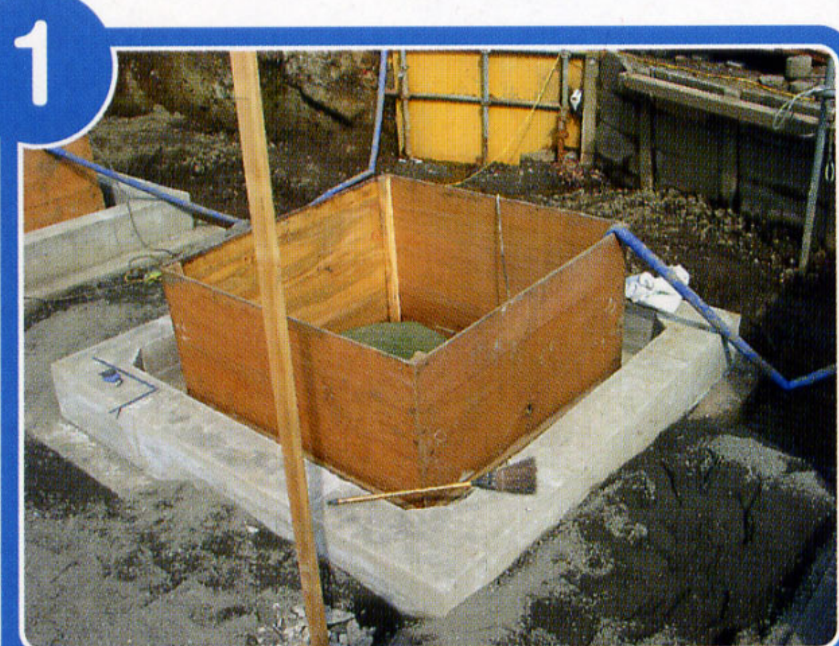
保護ピットの基礎を造る
