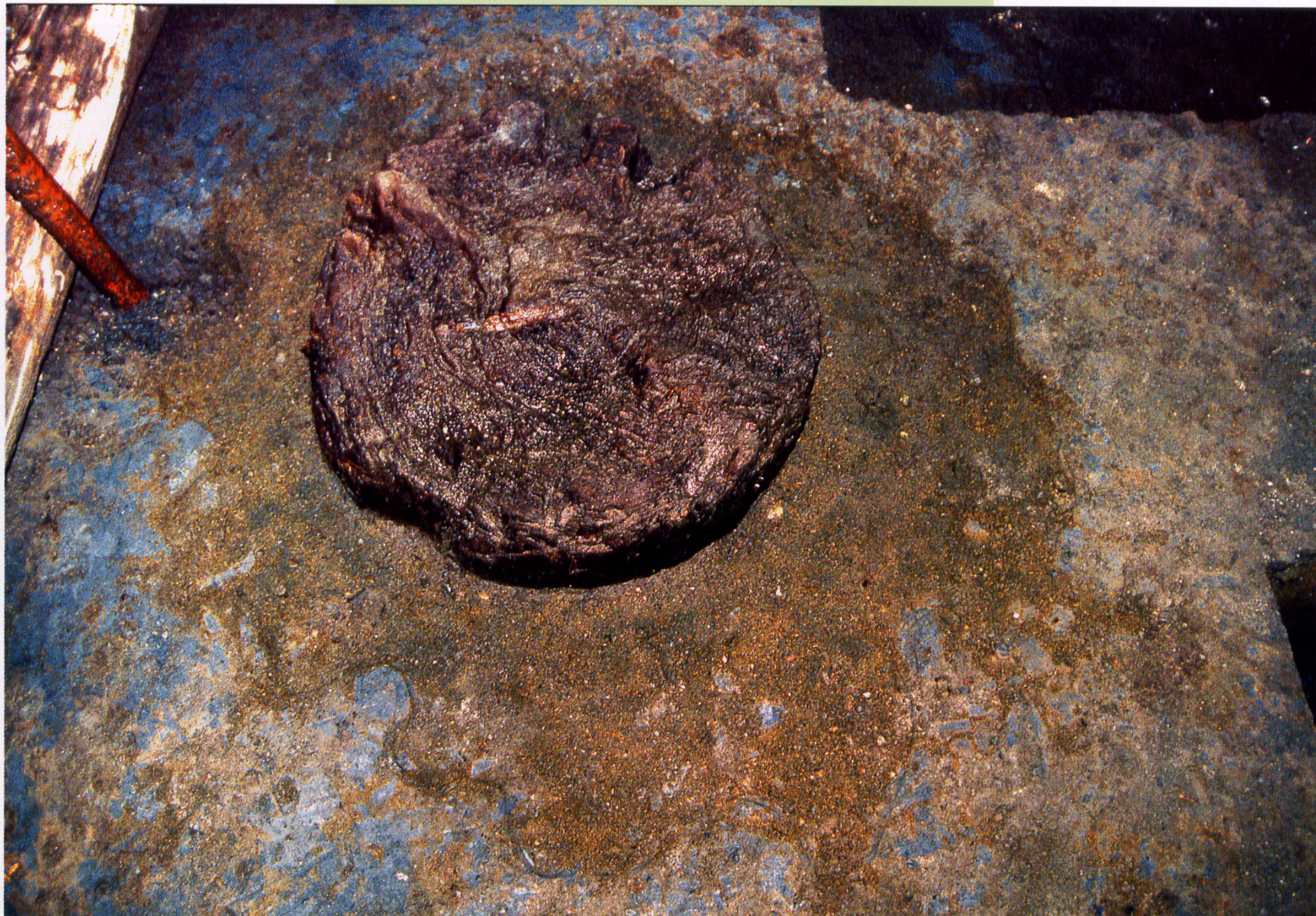
液状化によって噴き出した砂 橋杭No. 8の周囲には砂が花びらのように広がっていました。
