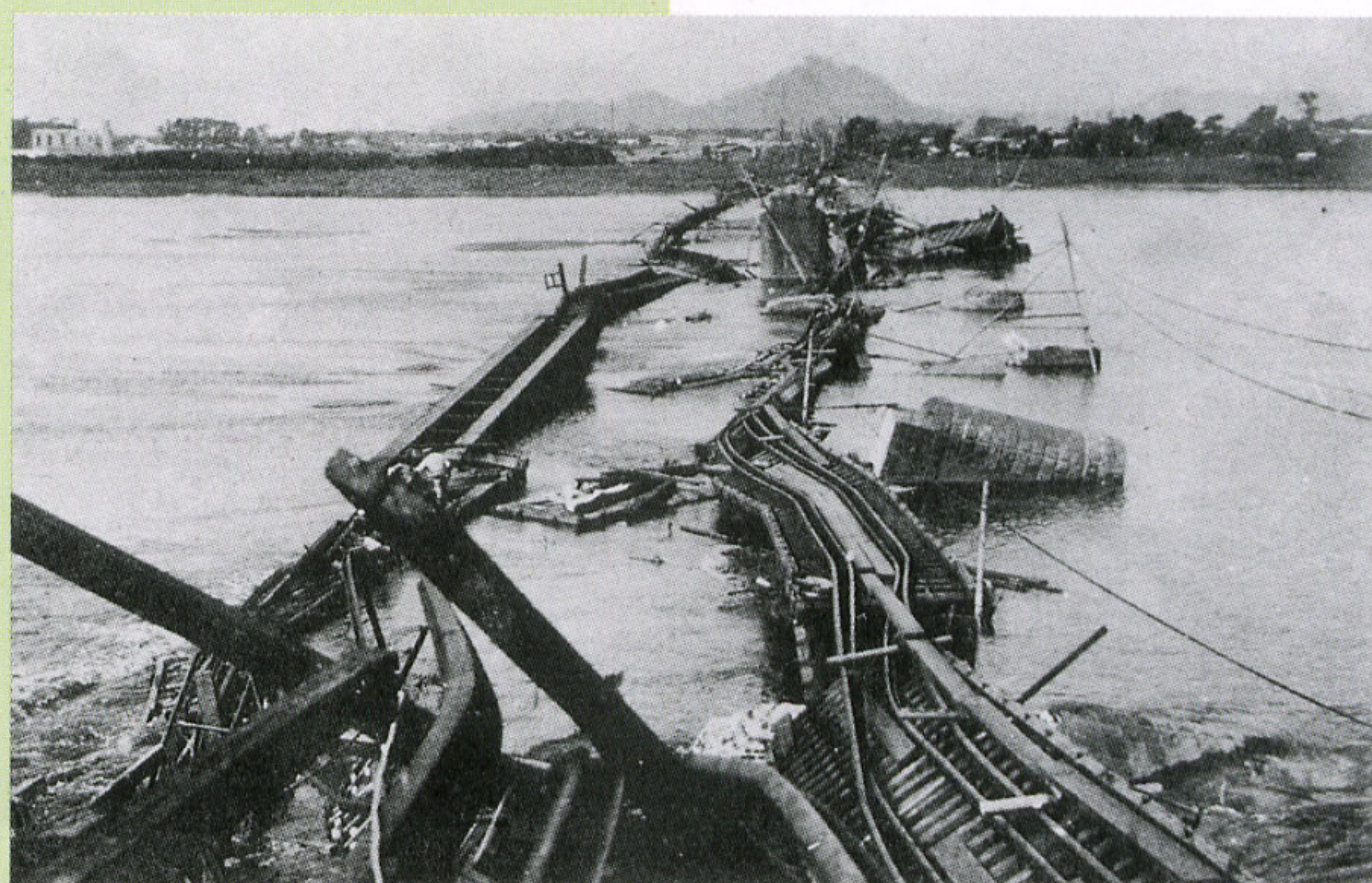
崩壊した馬入川鉄橋
