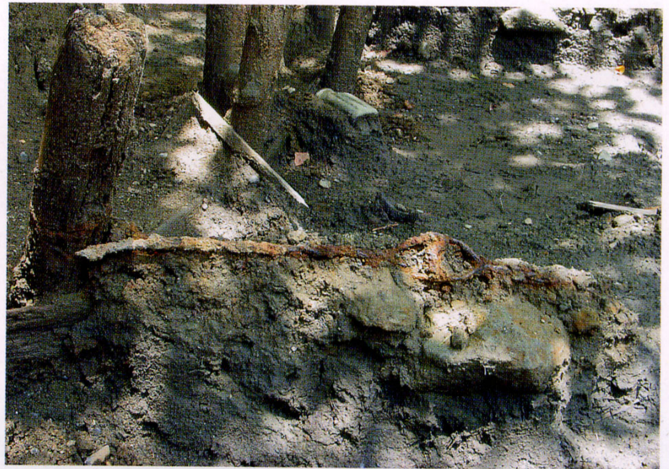
杭につながった針金 保存池北西部
