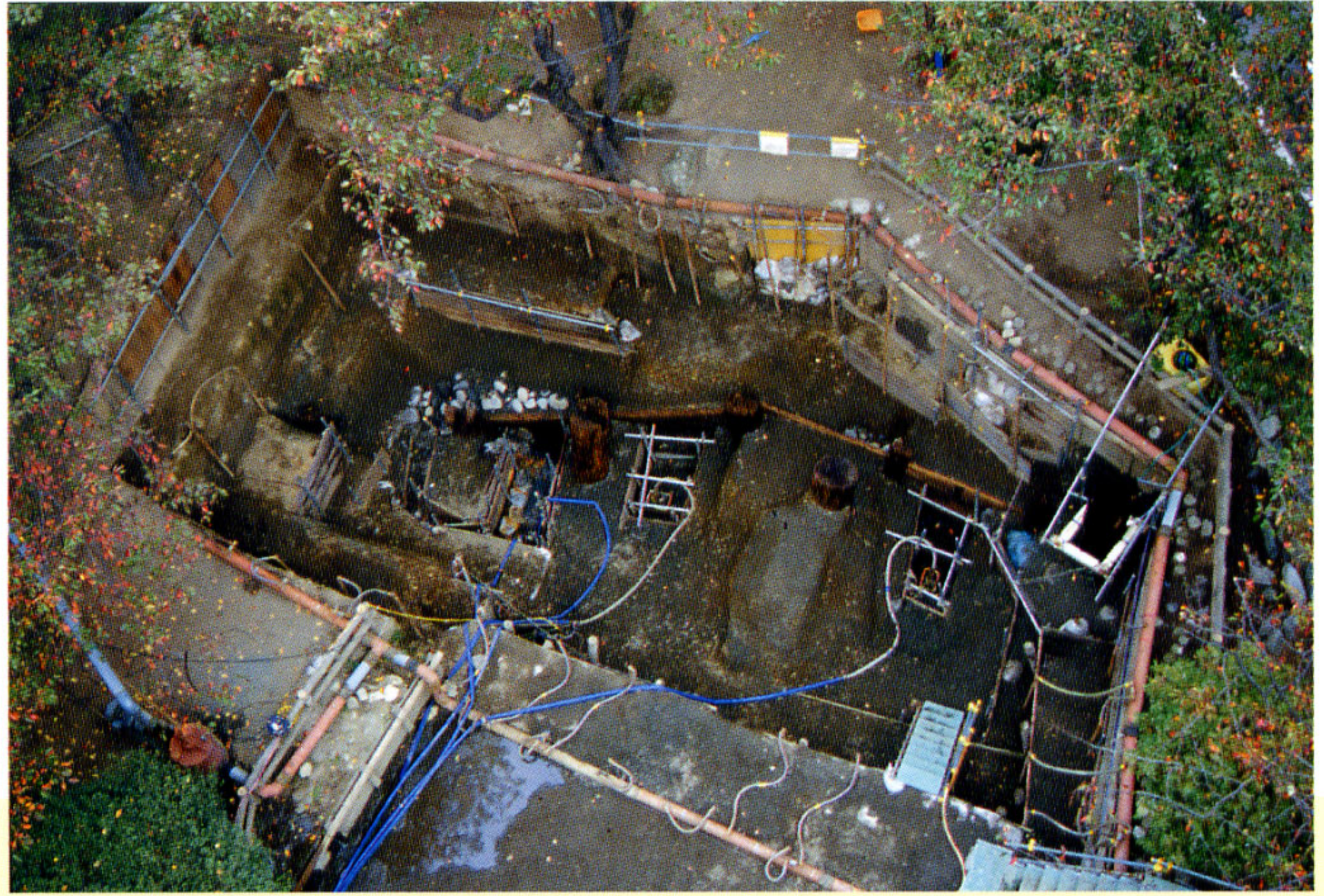
土留め遺構全景【南から】
