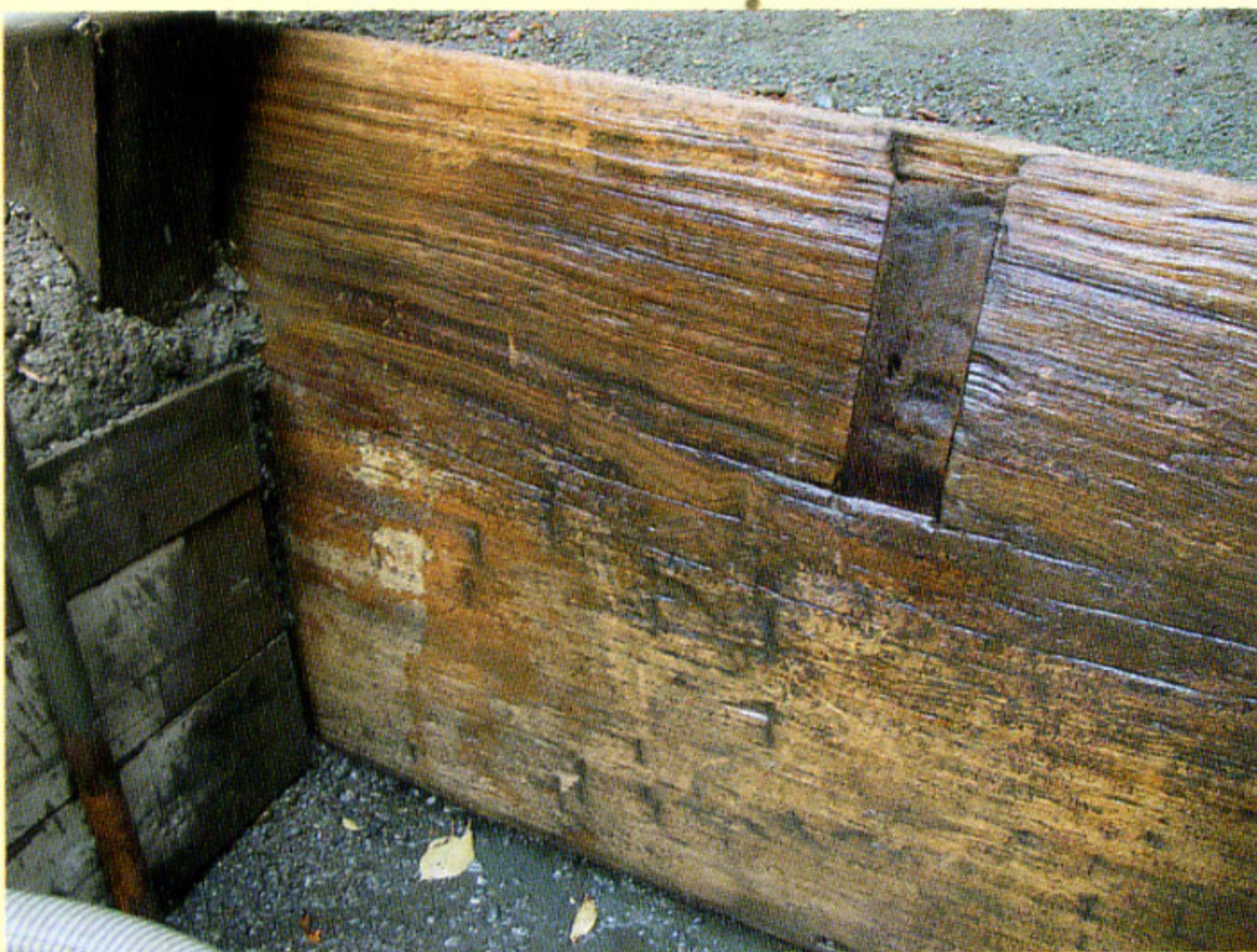
厚板東側【南から】
