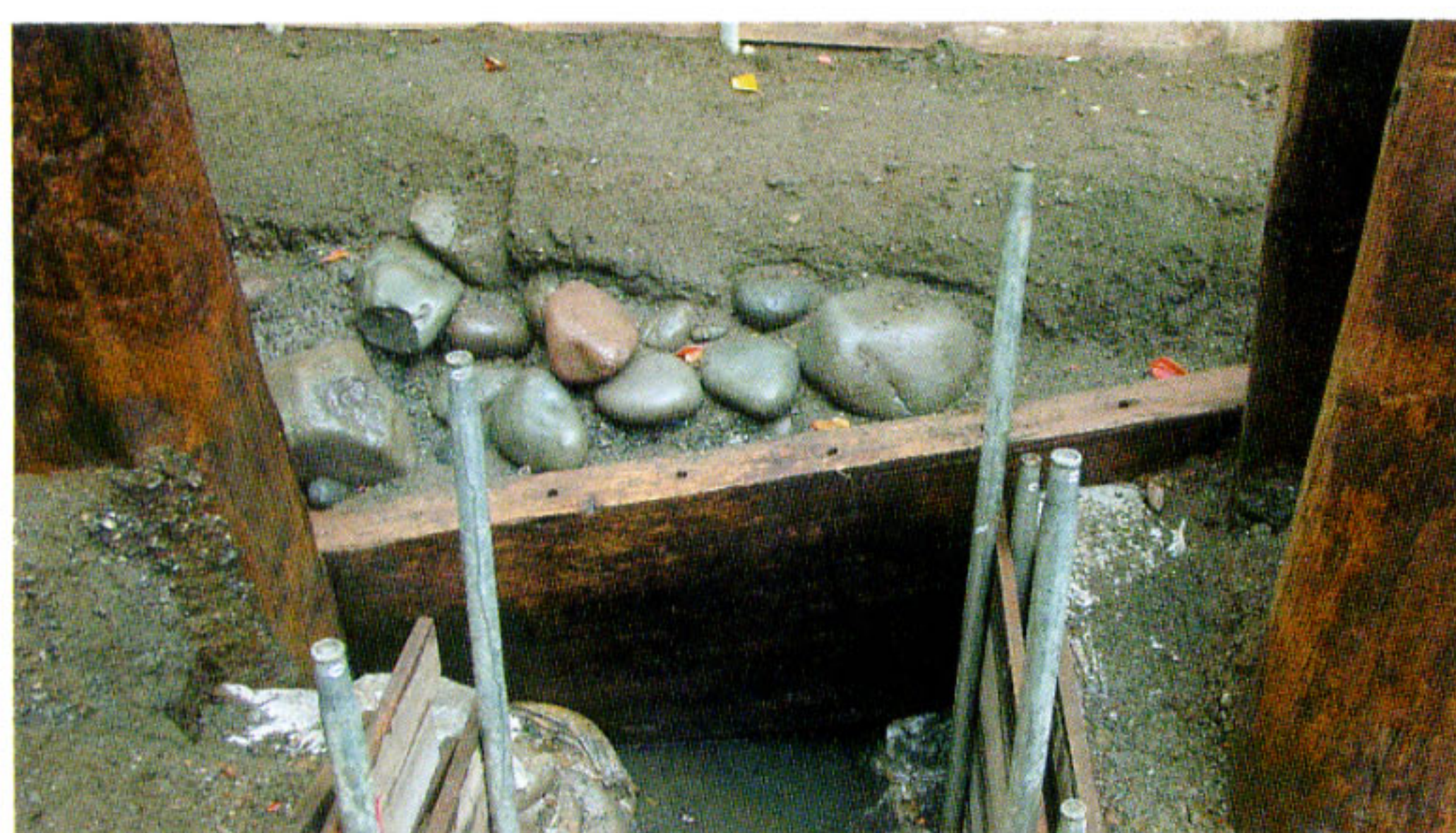
角柱4・5間の礫積み【南西から】
