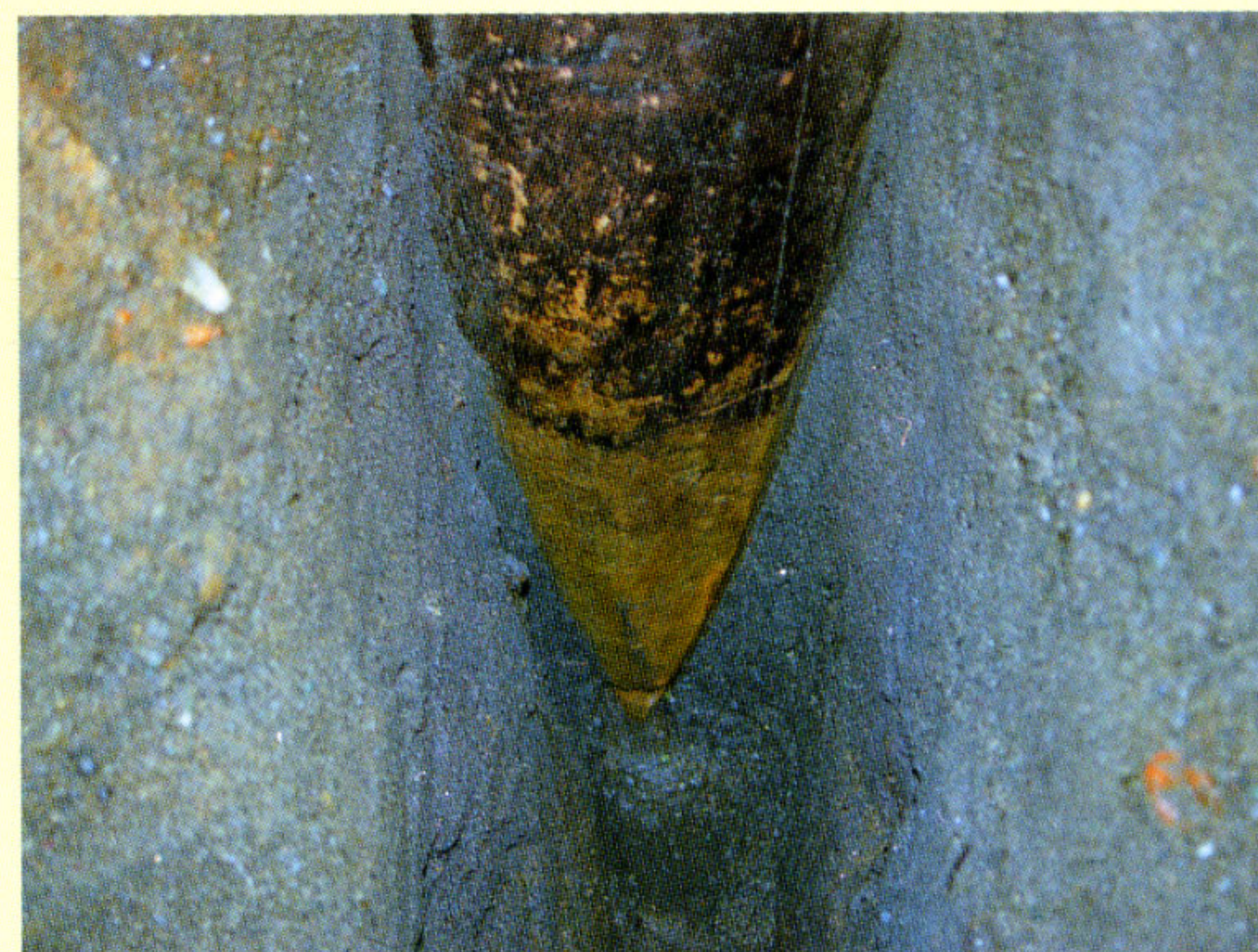
橋杭No.5の先端 杭のように尖っています
