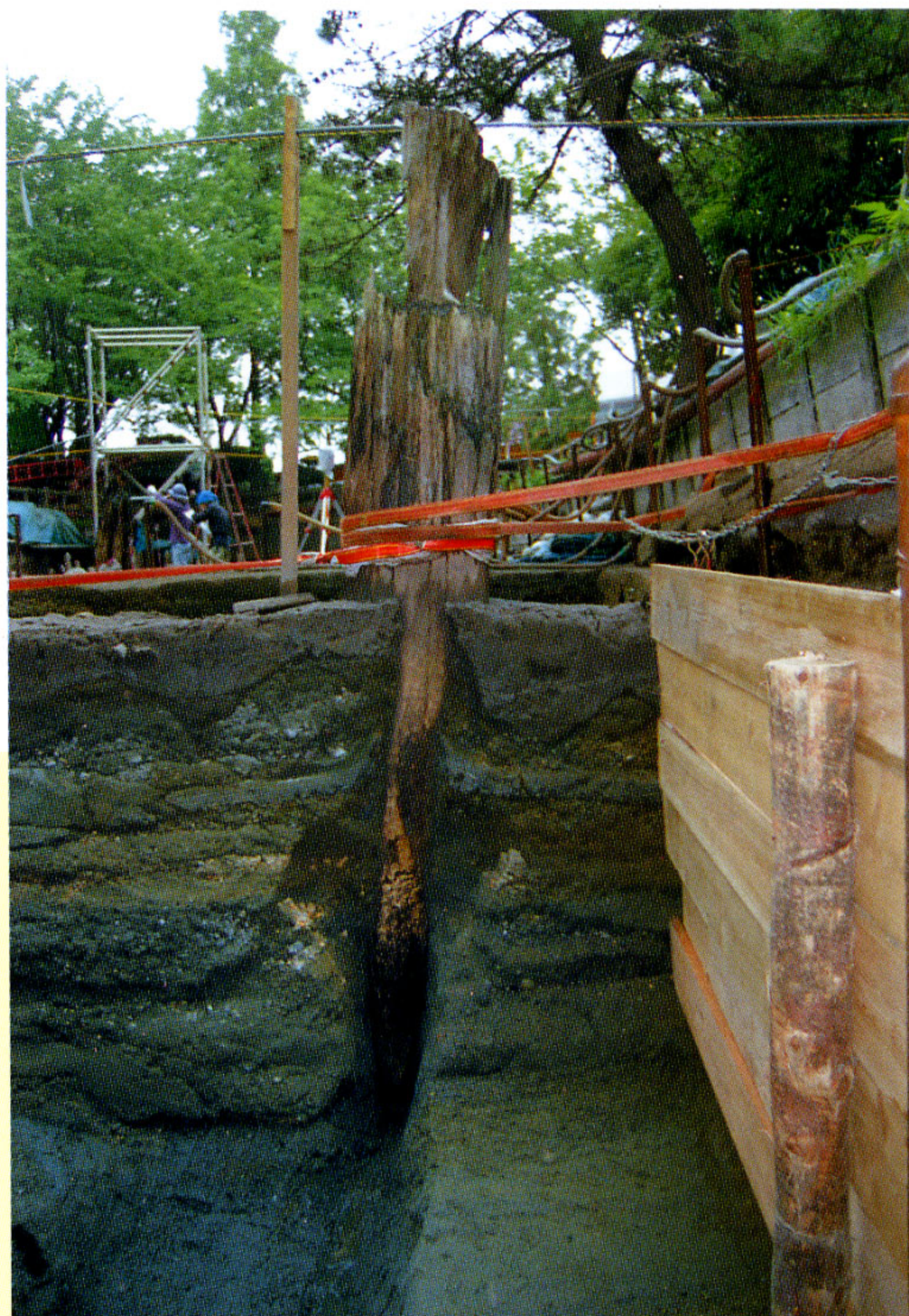
橋杭No.5の下部状況を見る
