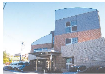
ちがさき 茅ヶ崎地区コミュニティセンター
