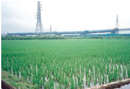
西久保の農地と建設中のさがみ縦貫道路
