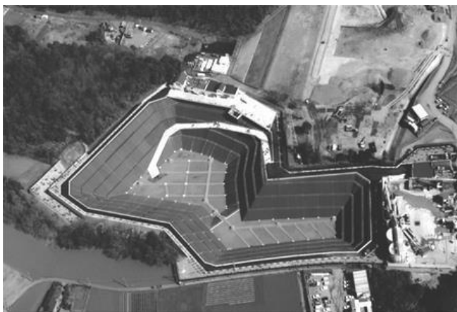
堤十二天一般廃棄物最終処分場
