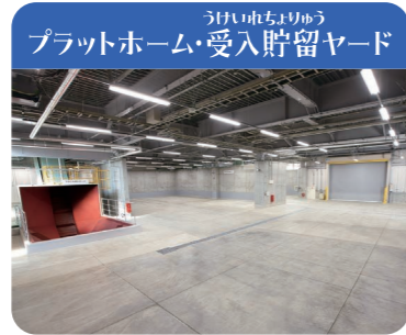
うけいれちりゆう プラットフォーム・受入貯留ヤード はんにゆう も おおがた 搬入された燃やせないゴミや大型ゴミ を、ここに貯めておきます。
