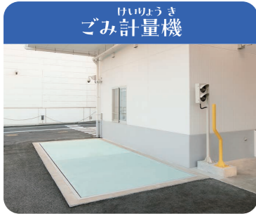
けいりょうき ごみ計量機 いりぐち つ くるま でぐち 入口でゴミを積んだ車を、出口でゴミを くるま(けいりょう) おろした車を計量します。
