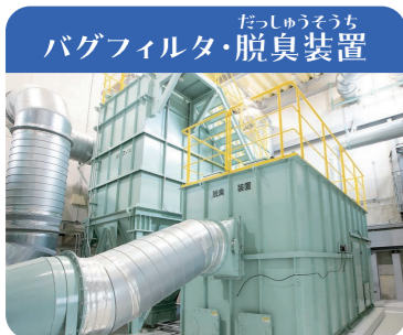
たっしゅうそうち バグフィルタ・脱臭装置 しせつ で くき よご 施設から出る空気の汚れやニオイを と のぞ きれい 取り除いて、綺麗にします。
