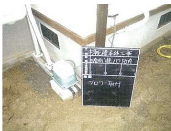
【写真10】 ブロワの設置状況を示す写真。
