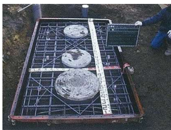
【写真8】 かさ上げの状況を示す写真。
