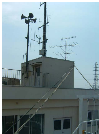
消防通信指令庁舎
