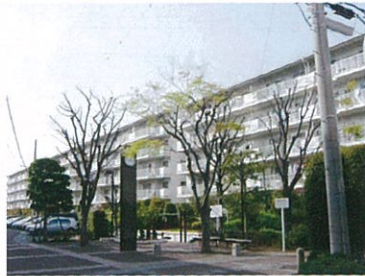
サニータウンは津波一時避難所
