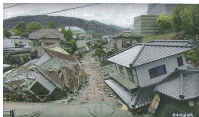
住宅が倒壊して道路をふさぐ 消防車・救急車は通れない！
