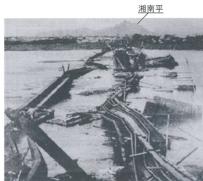
崩壊した馬入川鉄橋
