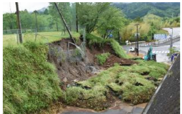
土砂崩れによる被害状況
