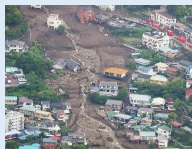
令和3年7月伊豆山土砂災害
