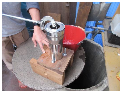
手押し式簡易ポンプの様子
