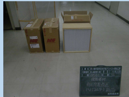
◆负压除塵装置 ヘパフィルター
