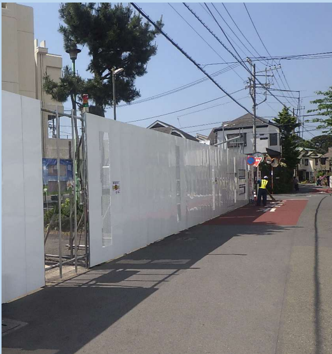
仮囲い設置例
