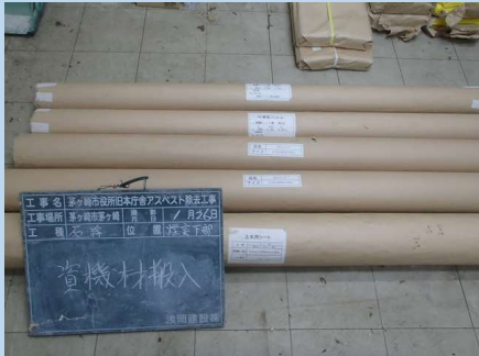
◆養生用ポリシート
