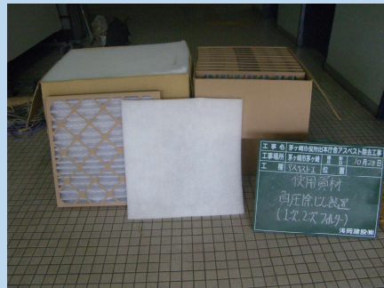
◆负压除塵装置 1次・2次側フィルター
