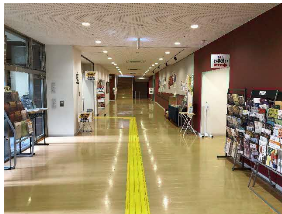
建物の内の通路にも視覚障がい者誘導用ブロックを連続的に設置【茅ヶ崎市民文化会館】
