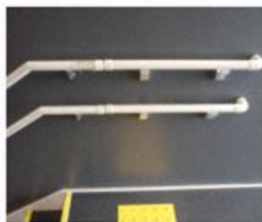
階段手すり延長
