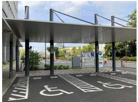
車いす利用者用駐車施設から主要な出入口までの経路に屋根を設置【茅ヶ崎市役所】
