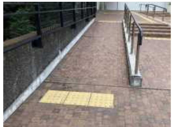
出入口手前に設置されたスロープ【茅ヶ崎市民文化会館】
