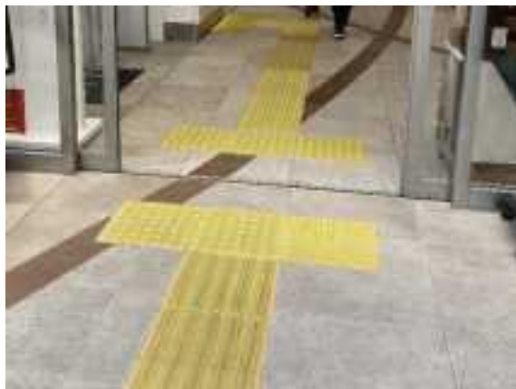
駅自由通路から出入口、インフォメーション(有人)まで視覚障がい者誘導用ブロックを連続的に設置【ラスカ茅ヶ崎】
