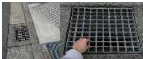
グレーチング改良(実施前)
