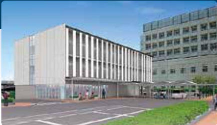
市立病院別棟外観
