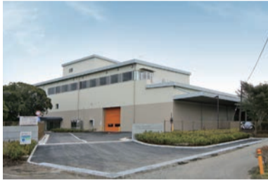
③寒川広域リサイクルセンター(寒川町)
