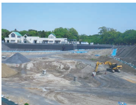
堤十二天一般廃棄物最終処分場
