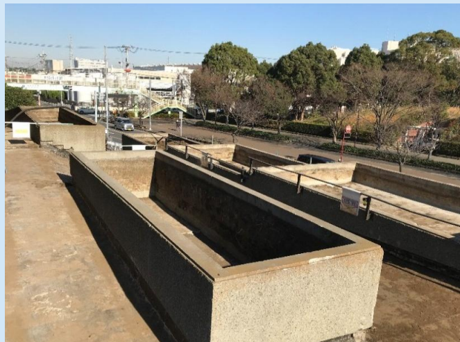
植栽帯客土撤去
