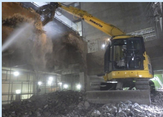
内部躯体解体
