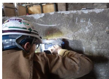
鉄筋探査状況
