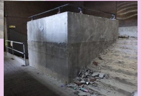
タイル撤去後
