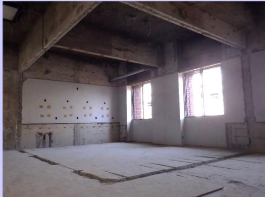
内部躯体解体
