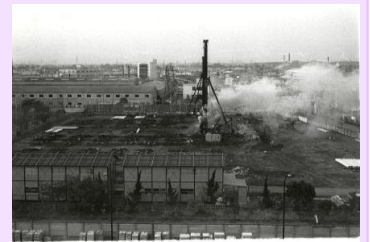
昭和54年春頃 地業工事
