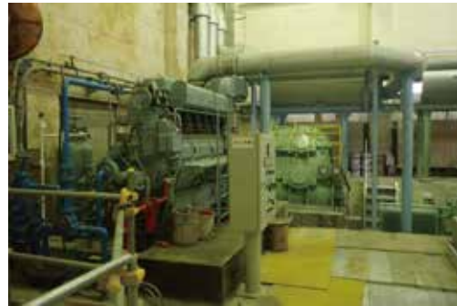
更新前の駆動装置 (エンジン・減速機)
