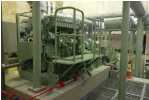
更新後の駆動装置 (エンジン・減速機)
