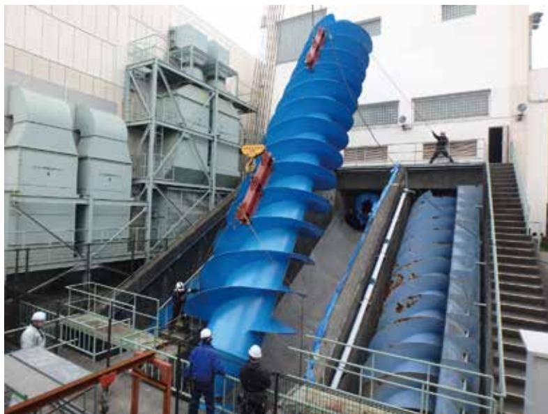
スクリーポンプ据付状況 口径:φ3,000mm 吐出量:196.2m 3 /min
