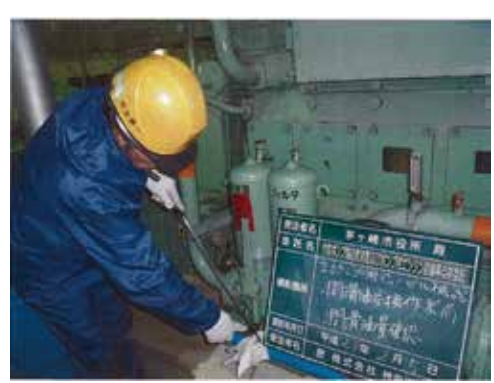
ポンプ用エンジンの点検の様子
