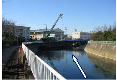
飯島橋下流区間 浚渫後
