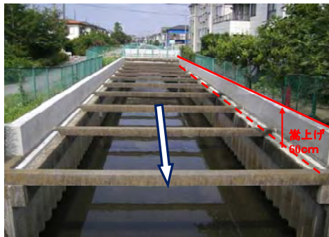
氾濫を防ぐ護岸の嵩上げ
