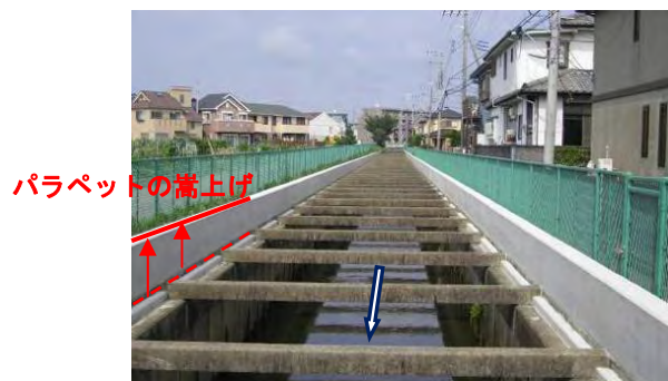
パラペットの嵩上げ 菱沼雨水幹線区間
