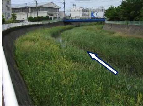
飯島橋下流区間 浚渫前
