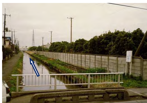
昭和 50 年代前半の千ノ川 千ノ川橋より下流を望む
