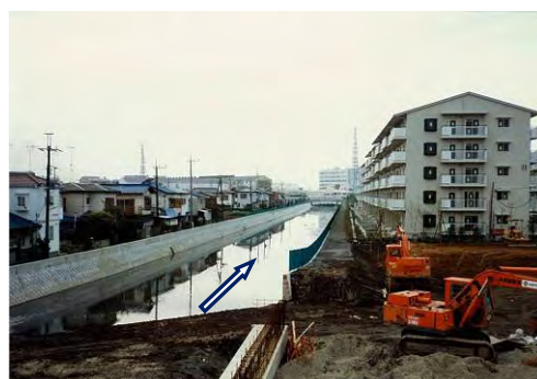
昭和 60 年代前半の千ノ川 千ノ川橋より下流を望む
