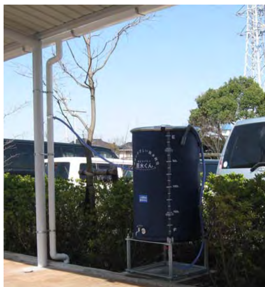
写真：雨水タンク設置状況 （茅ヶ崎市立病院敷地内）
