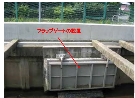
水が逆流しないように フラップゲート *1 を設置
