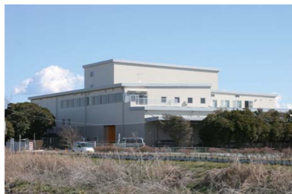
寒川広域リサイクルセンター
