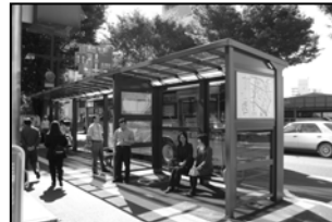
ハイレードバス停の事例 (群馬県前橋市)
