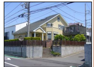
自然素材を用いた外観
