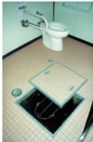
■ 公衆トイレの防災対応化の事例 （トイレ内スペースに災害用トイレを格納）
