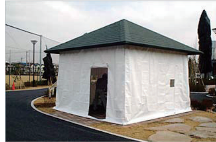
非常時はテントとして使用 (テントは屋根下に格納されている)
