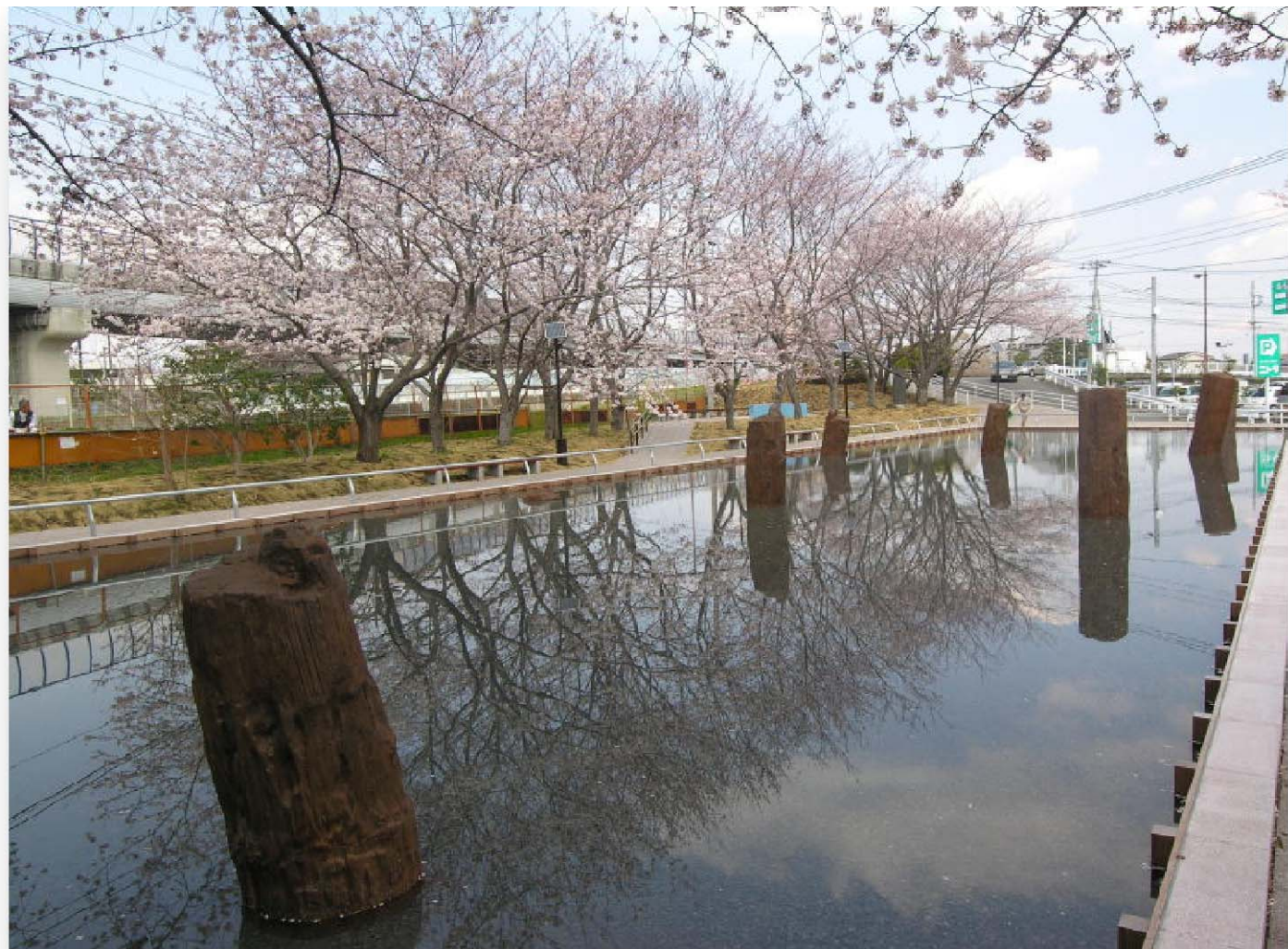
保存整備された橋脚
