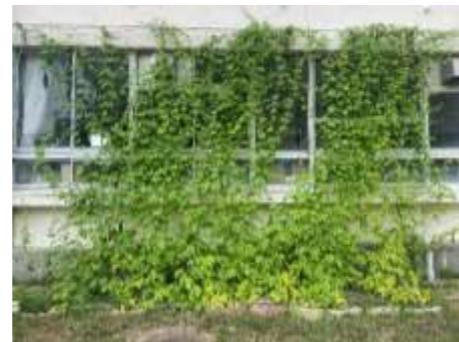
エアコンのない理科室にゴーヤのグリーンカーテンの設置
