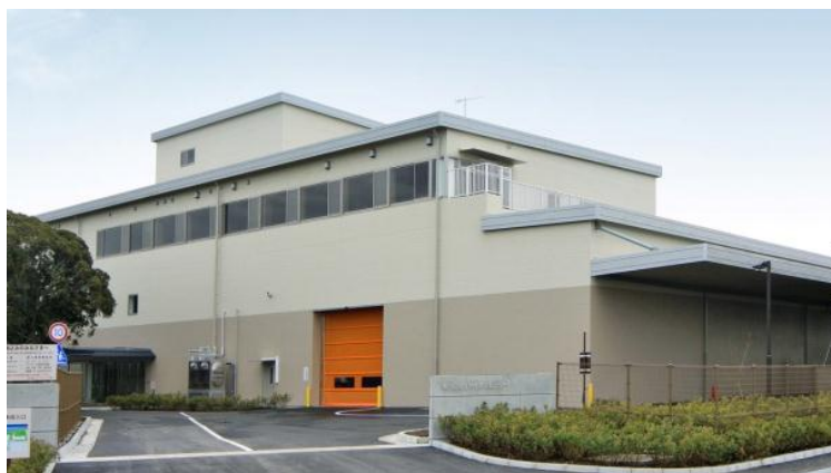
寒川広域リサイクルセンター
