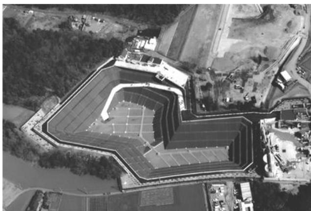
堤十二天一般廃棄物最終処分場
