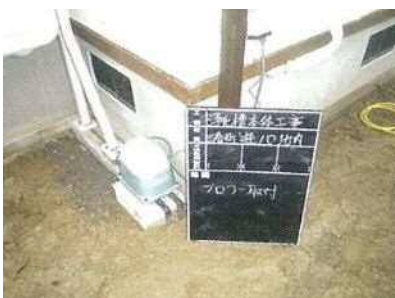
【写真10】 ブロワの設置状況を示す写真。
