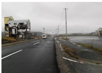
かさ上げしている道路（門脇地区）
