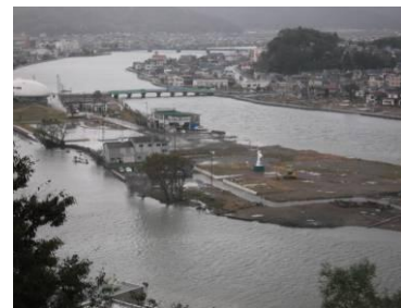
日和山から見た中瀬地区
