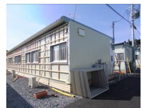
外壁の上から断熱材を貼る様子
