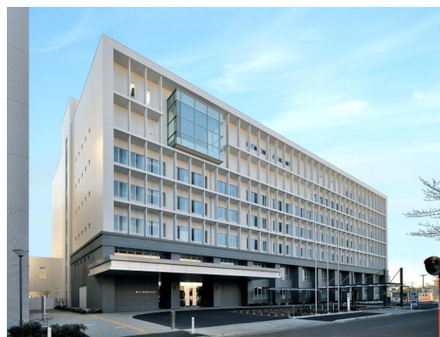
消防本部 (茅ヶ崎市役所 4 階)
