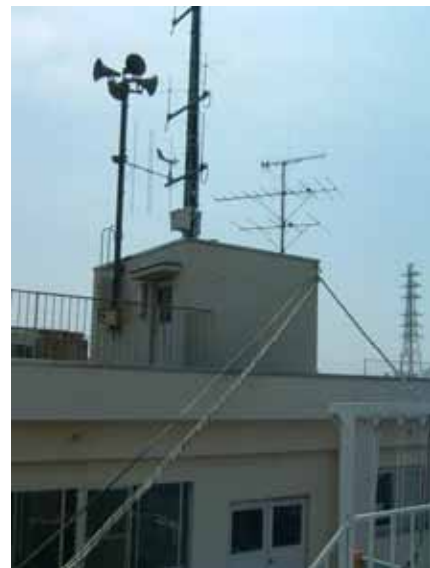
消防通信指令庁舎
