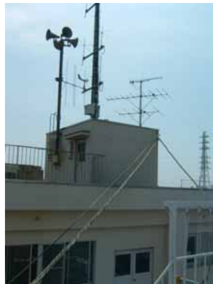
消防通信指令庁舎
