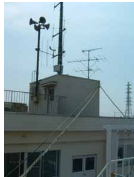
消防通信指令庁舎
