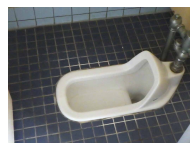
改修予定の体育館和式トイレ
